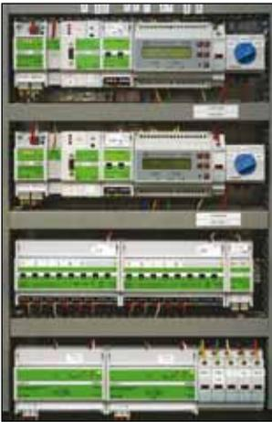
**Figure 3.** Composants de KNX dans la salle de mesures du dernier étage.
